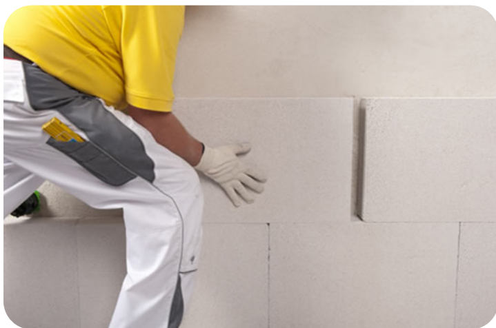
Постављање топлотне изолације
