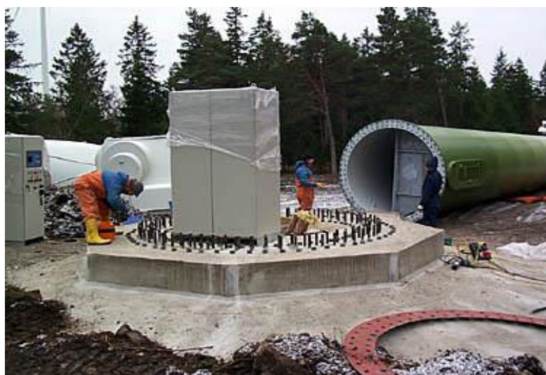
Slika 52. Montaža vjetroelektrane
