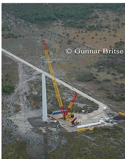
Slika 51. Izgradnja temelja i temeljnog stuba vjetroelektrane
