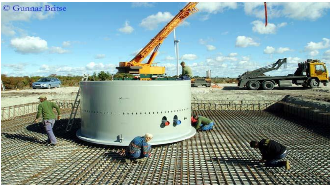
Slika 51. Izgradnja temelja i temeljnog stuba vjetroelektrane
