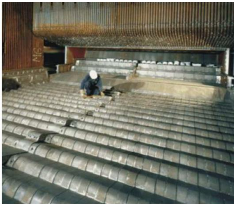
Slika 14. Prikaz pokretnih rešetki
