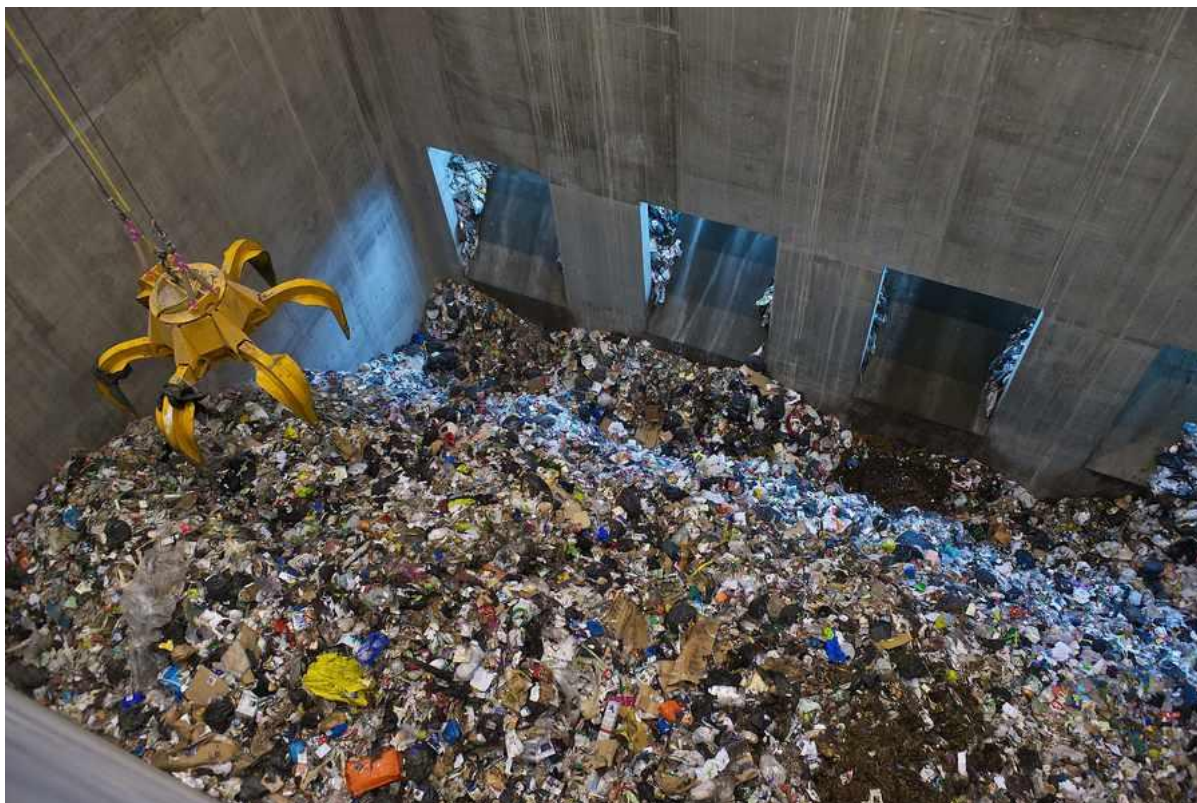
Slika 16. Bunker za komunalni otpad sa hvataljkom - grajferom za otpad
