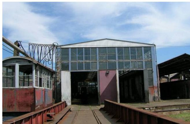
Sl. br. 50- Hala za popravku osovinskih sklopova
