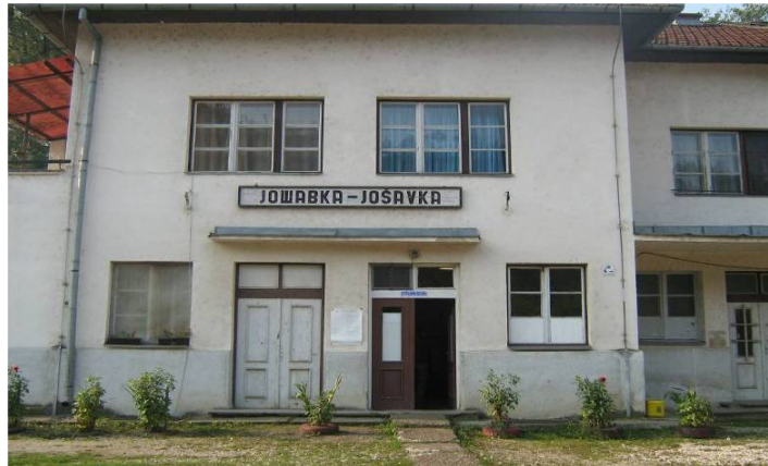
Sl.br.9- Željeznička stanica Jošavka
