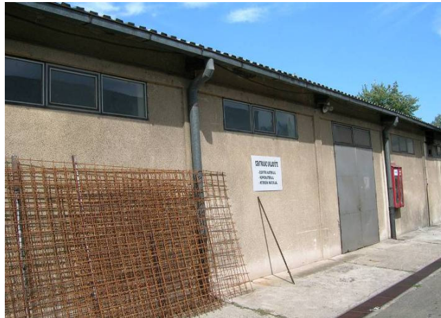
Sl. br. 60-Skladište praznih boca i alata
