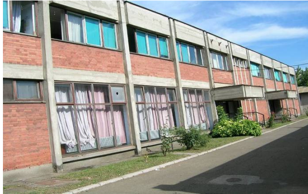
Sl.br.35- Upravna zgrada sekcije OŠV
