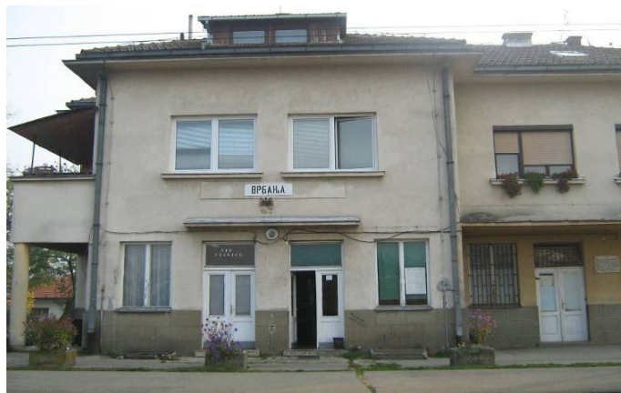
Sl.br.4- Željeznička stanica Vrbanja
