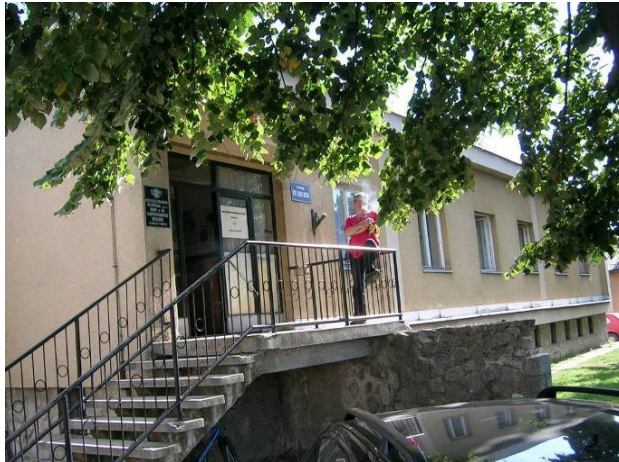
Sl. br. 74-. Upravna zgrada sekcije ETP-a
