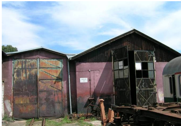
Sl. br.36-Hala za dnevni pregled vagona
