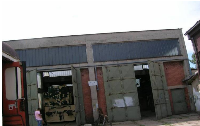
Sl. br.39-Hala za pranje i opravku željezničkih vozila
