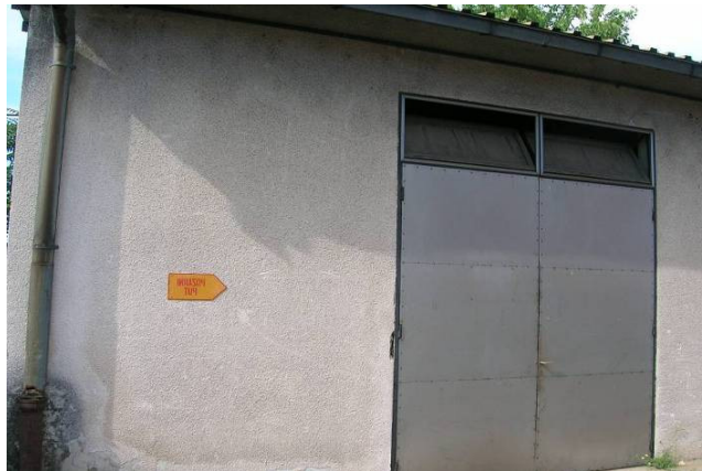
Sl. br.- 48. Skladište tečnih gasova
