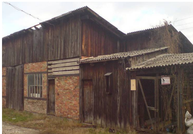
Sl. br. 67- Skladište praznih boca i alata
