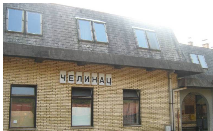
Sl.br.6. - Željeznička stanica Čelinac
