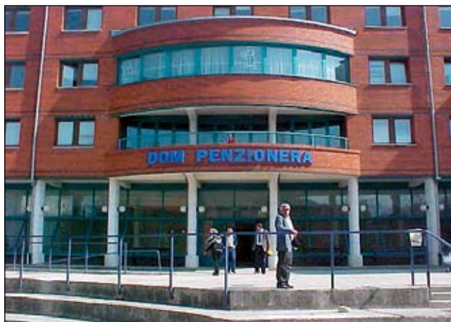
Дом пензионера Приједор "Elderly people's home" in Prijedor
